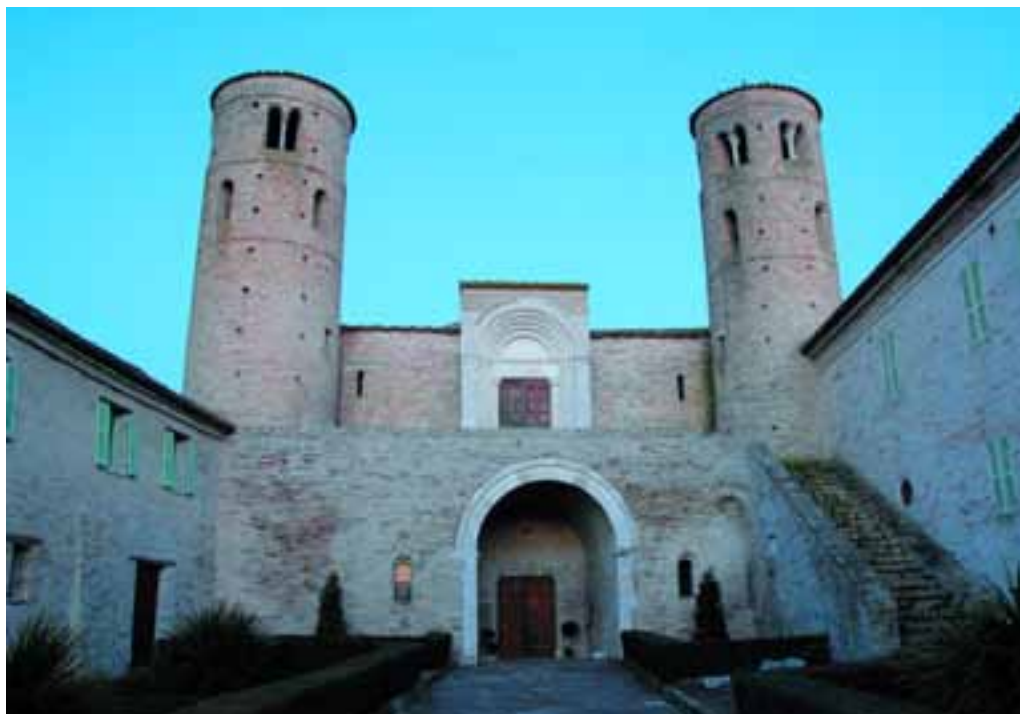
Abbazia di S. Claudio: la facciata.
